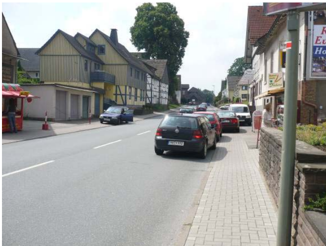
Ortsdurchfahrt mit ungelöster Stellplatzgestaltung
