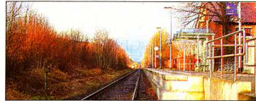
Die Umgehungsstraße wird links neben den Gleisen gebaut. Direkt daneben – ebenfalls noch links neben der Bahnlinie – steht eine vier Meter hohe Lärmschutzwand. Das Foto entstand am Bahnhof. Foto: R. Struck
