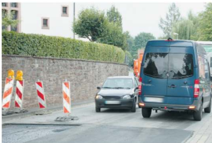
Falschfahrer: Viele Autofahrer missachten das Fahrverbot und verursachen dadurch gefährliche Situationen. FOTO: SABINE HEINEMANN
