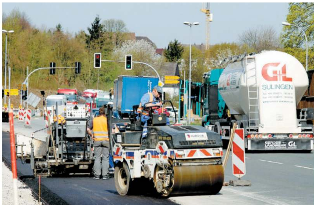
Baubeginn: In der Kernstadt laufen die Arbeiten bereits. Ab nächster Woche soll dann der Schwerlastverkehr weiträumig umgeleitet werden.
